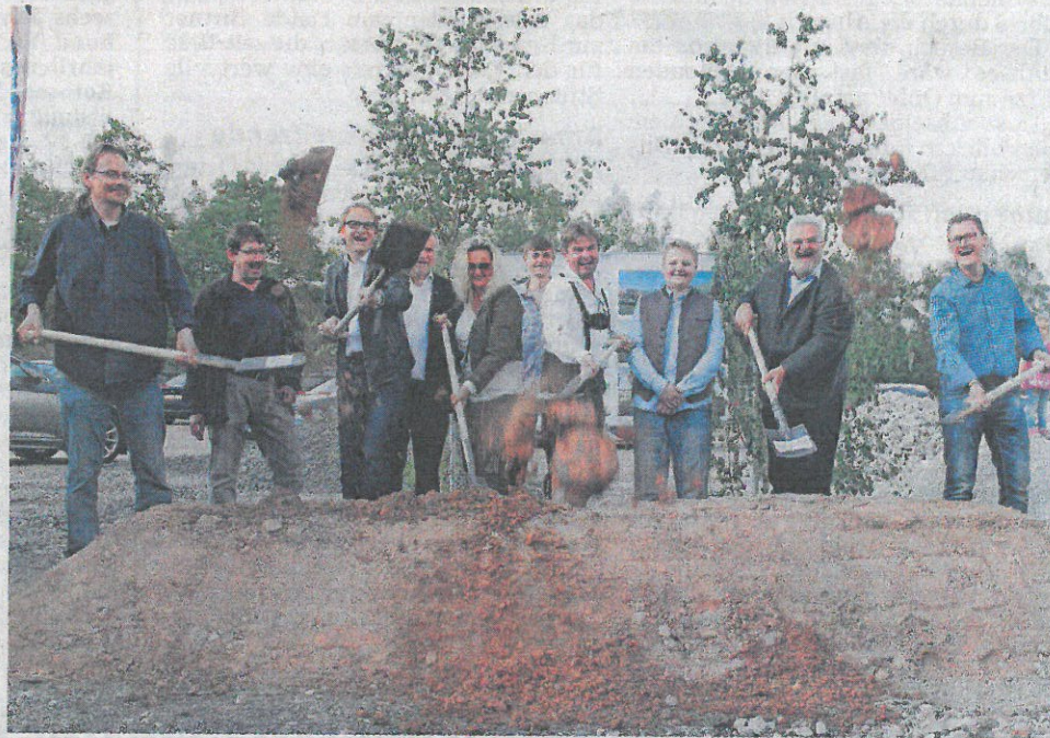
Firmenangehörige und der Kammersteiner Bürgermeister Walter Schnell beim „ersten Spatenstich“ am neuen Standort der Firma Biedenbacher. Foto: Scherbel
